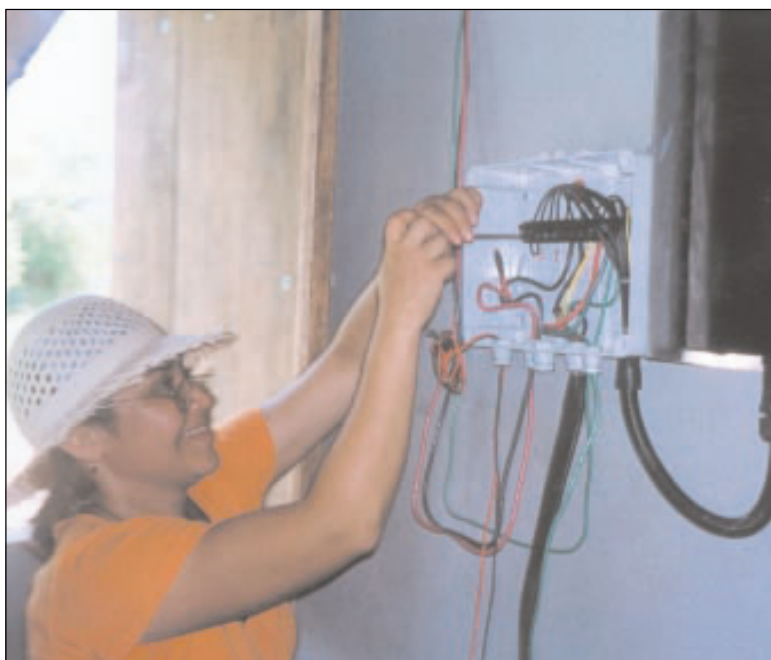
Figure 4 (Adesol – Asociacion para el desarrollo de la energia solar) technician Ethel Enamorado connects control box wiring
